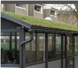
Buet tak med sedum
