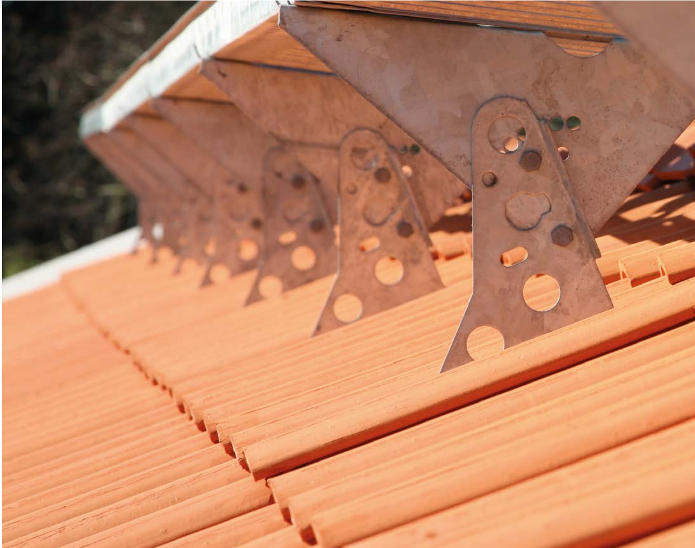
Konsoll med brofeste på tak med teglstein.
