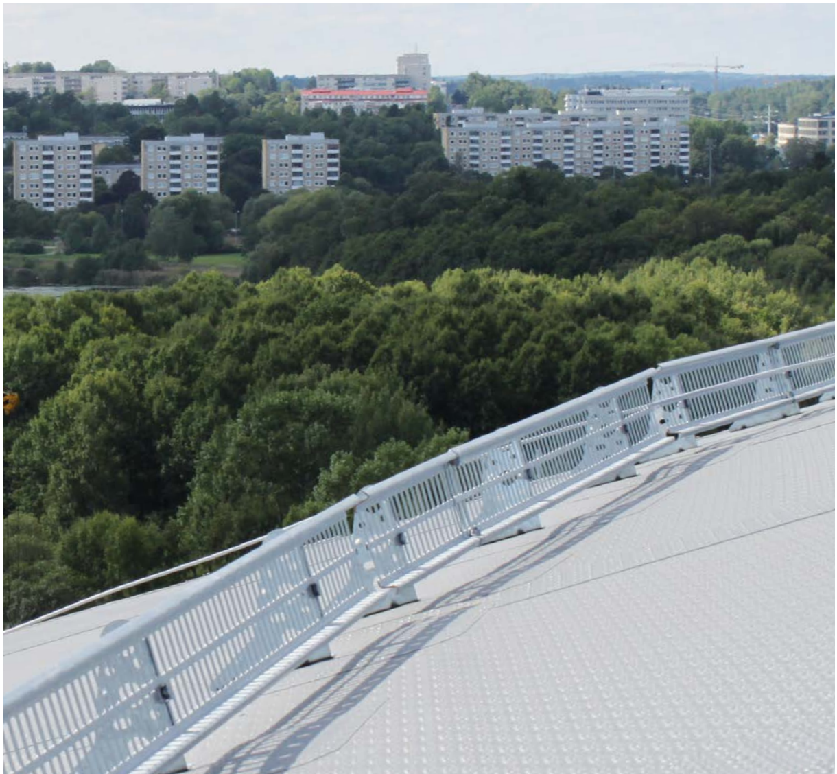
Snøfanger montert på flat festeplate
