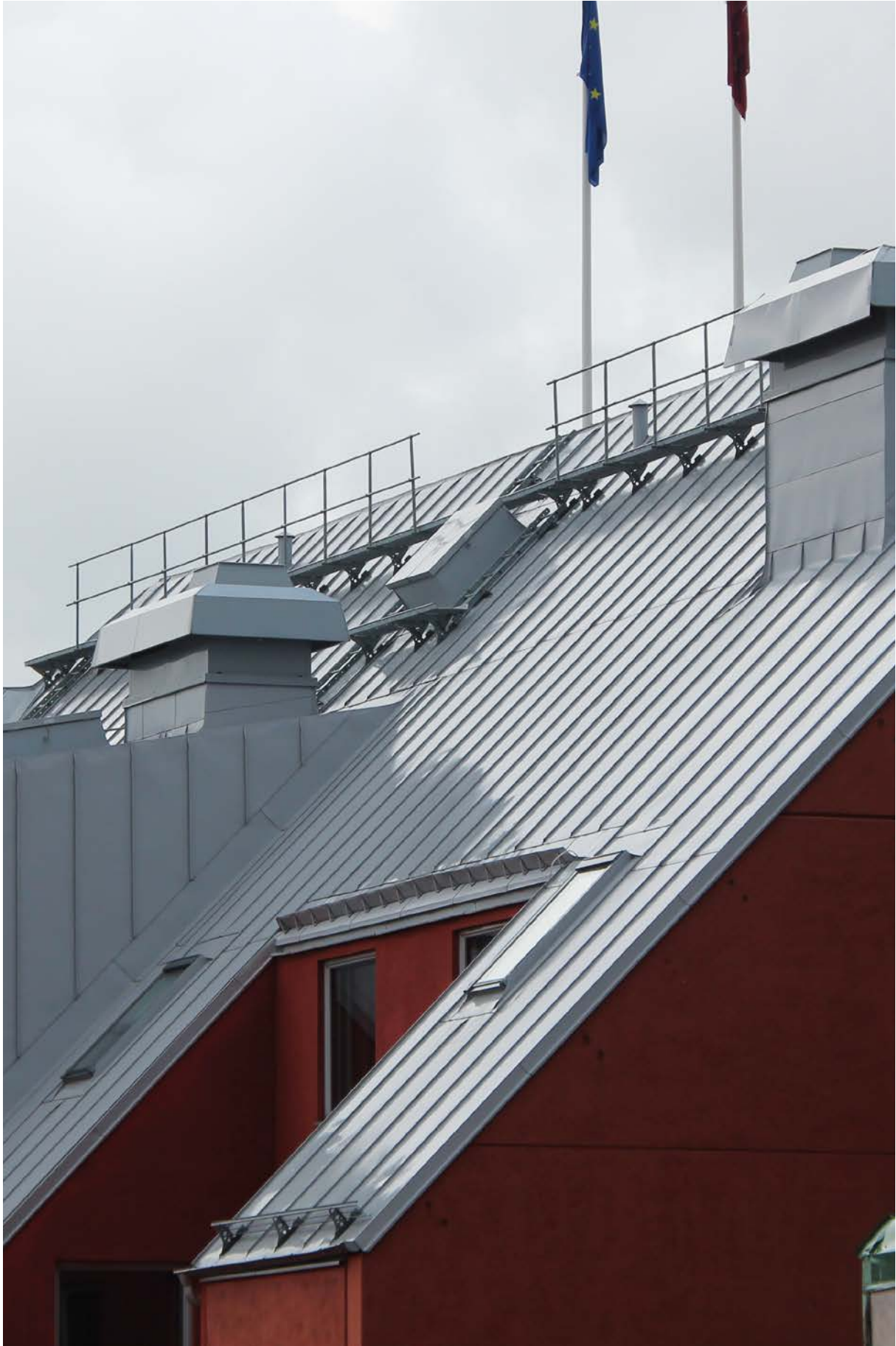
Takbro med rekkverk, 1100 mm.
