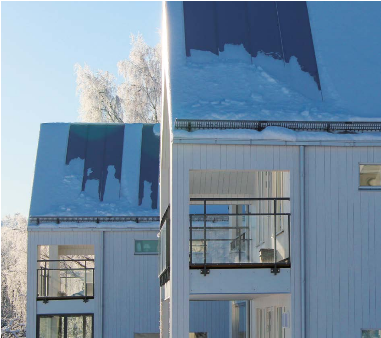
Snøfanger i profilrist med isstopper montert på båndtekket tak.
