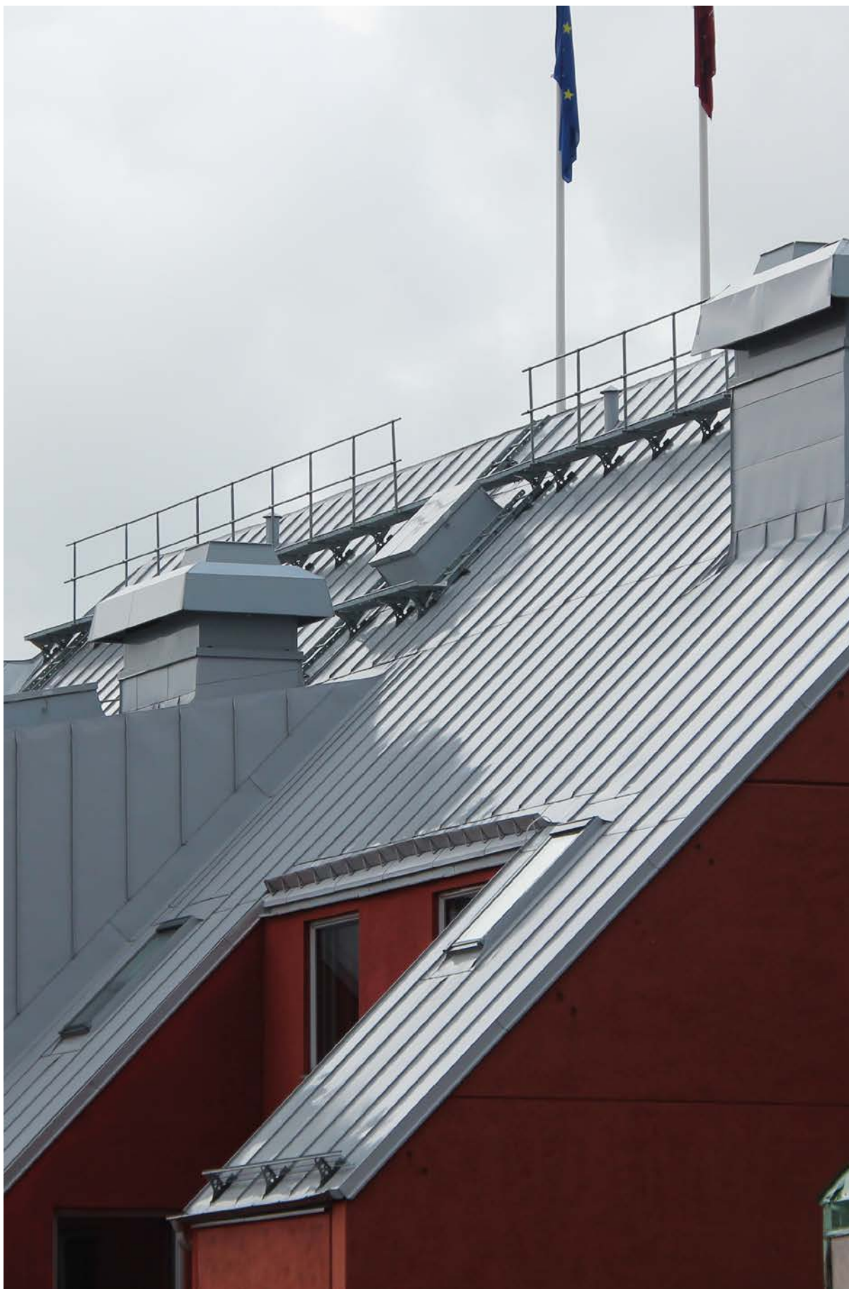
Takbro med rekkverk, 1100 mm.
