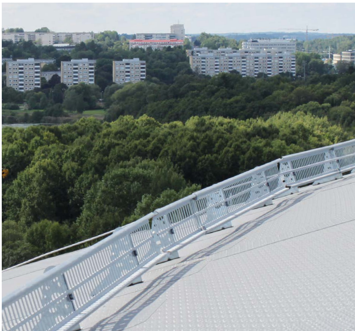
Snøfanger montert på flat festeplate
